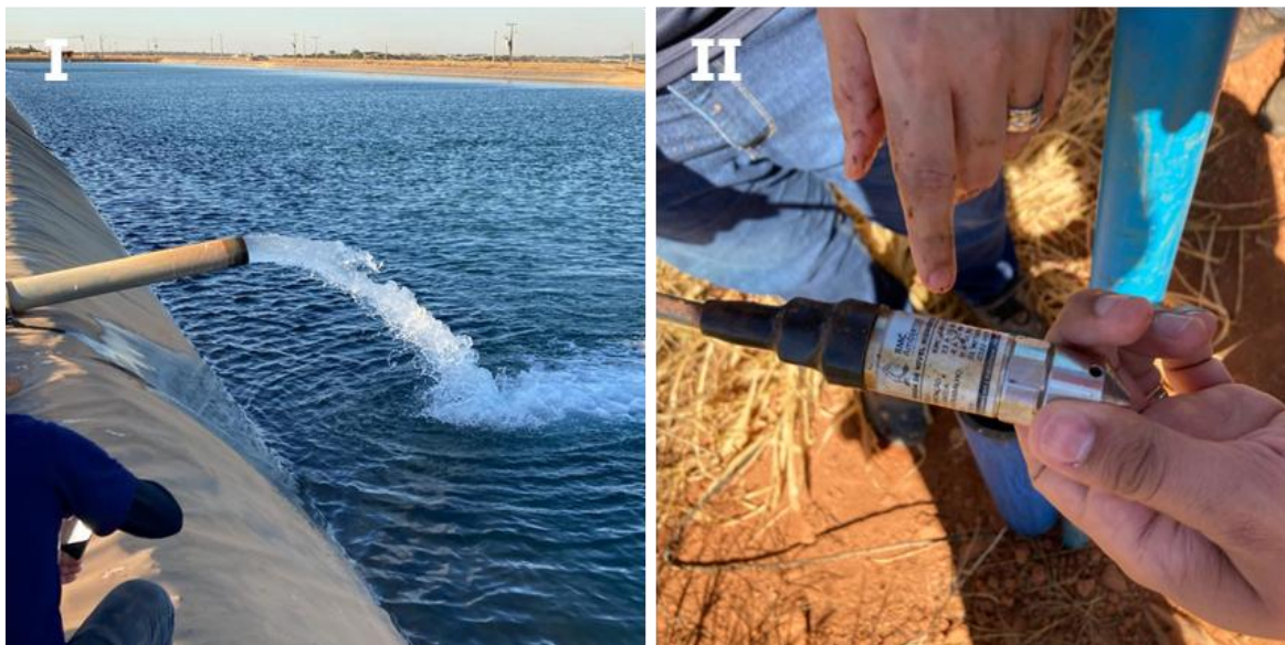
Figura 5.16 - (I) Vazão resultante dos poços tubulares profundos abastecendo o reservatório na Faz. Rio Manso. A vazão individual chega a 250 m 3 /h. (II) Detalhe do sensor e datalogger automático de nível d'água dos poços.
