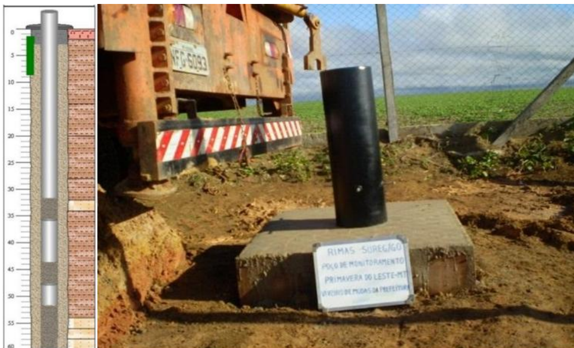
Figura 5.52 - Poço de monitoramento (5200007036) da RIMAS/SGB/CPRM instalado em Primavera do Leste (MT) e seu perfil geológico/construtivo (à esquerda), onde se observa: o poço tubular com as zonas de filtros situadas entre 32-36 m, 44-48 m e de 52-60 m de profundidade; o pré-filtro, que ocorre em toda a extensão do poço; as litologias de arenito – mais claro - e arenito argiloso – castanho escuro; e a posição do sensor de dados, em verde.
