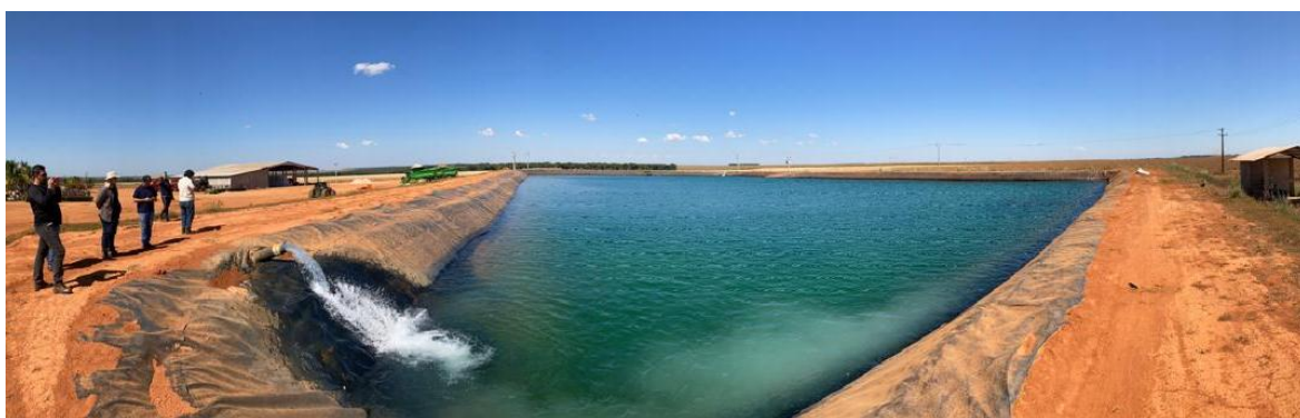
Figura 5.18 - Vazão resultante do bombeio de poços tubulares abastecendo o reservatório 01 na Faz. Rio Santo Antônio do Desejado. A vazão individual chega a 290 m 3 /h, conforme a leitura do hidrômetro e estimativa na tubulação.
