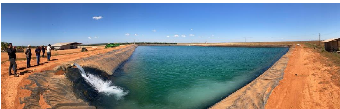
Figura 4.18 - Vazão resultante do bombeio de poços tubulares abastecendo o reservatório 01 na Faz. Rio Santo Antônio do Desejado. A vazão individual chega a 290 m 3 /h, conforme a leitura do hidrômetro e estimativa na tubulação.
