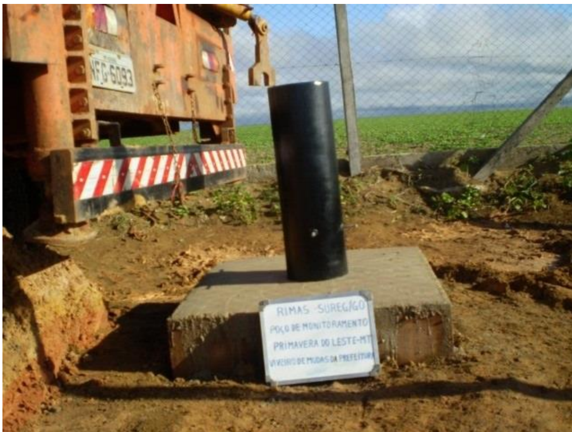
Figura 4.3 - Poço de monitoramento (5200007036) da RIMAS/CPRM instalado em Primavera do Leste.
